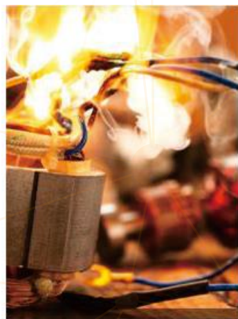
حفاظت از کابل ها
